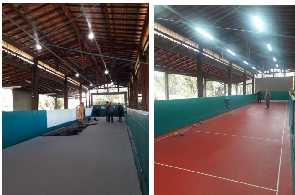
Figura 30: Reforma do piso da cancha de bocha
