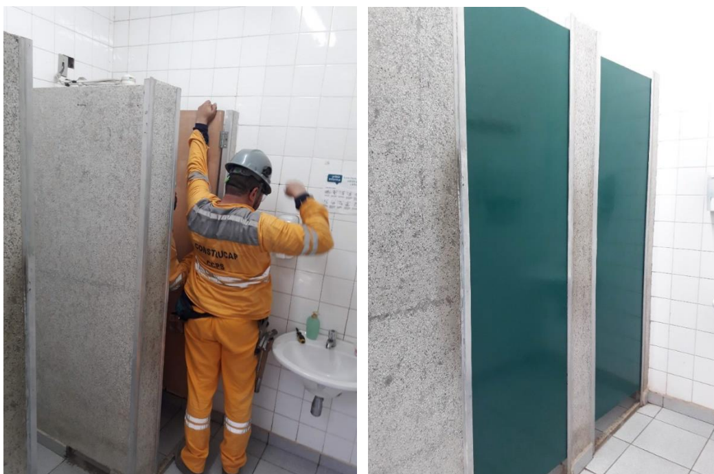
Figura 36: Instalação de portas na área dos chuveiros
