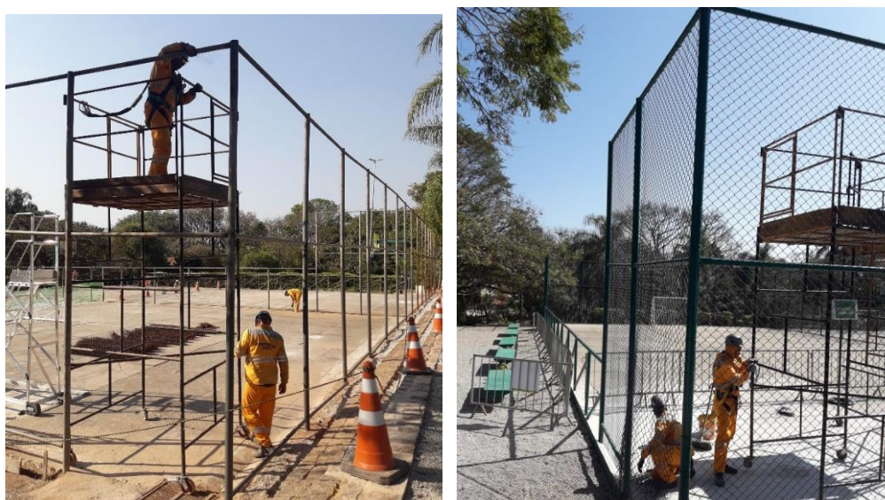
Figura 28: Troca de alambrados e manutenção das bases metálicas das quadras
