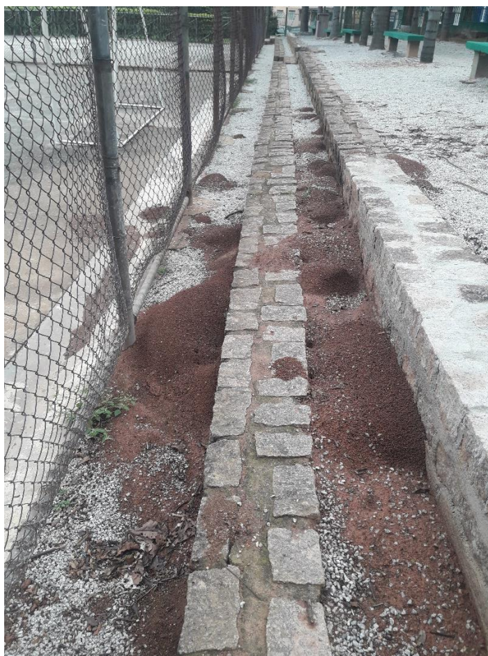
Figura 13: Formigueiro em área interna próximo as quadras poliesportivas
