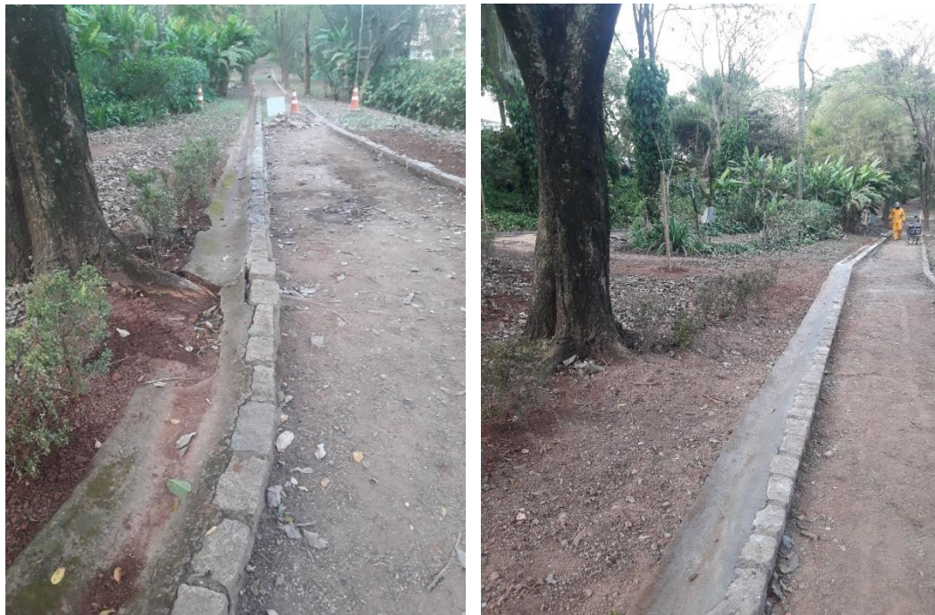
Figura 34: Adequação das canaletas
