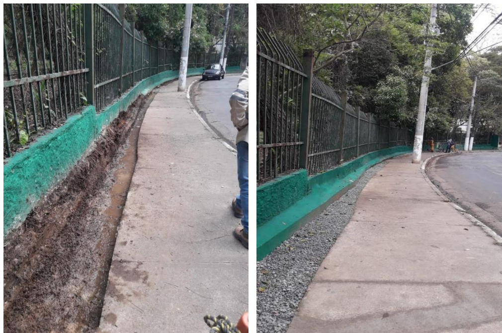
Figura 37: Manutenção calçada do lago/UBS (antes e depois)
