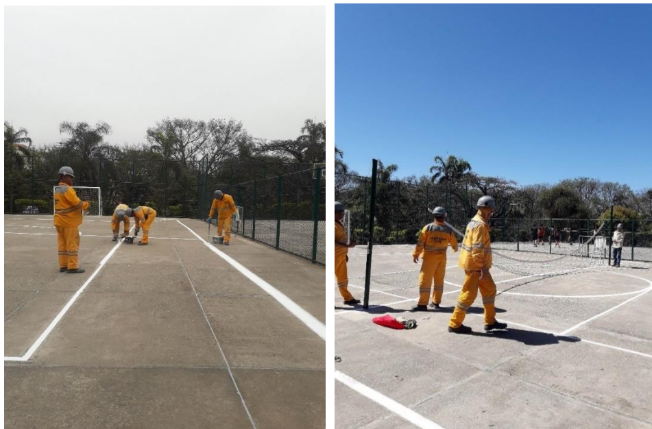
Figura 29: Reforma do piso da quadra, pintura e rede de vôlei
