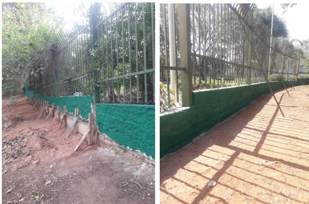
Figura 32: Recuperação e pintura de muretas internas.
